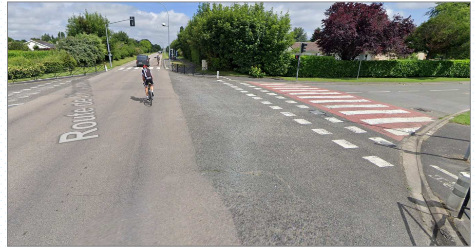
Carrefour avec l'avenue de l'Orangerie routier, doté de continuités latérales en bandes cyclables décalées mais sans véritable trottoir piéton
