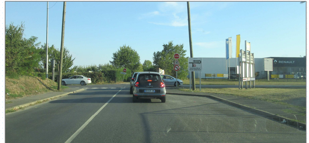
Rue de Tournenfil particulièrement large et routière, inadaptée à la pratique cyclable
