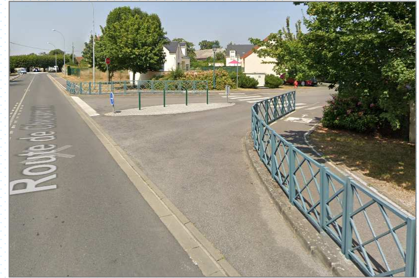
Traversées de la rue des Vives Eaux trop routière et évasée vers une rue de desserte
