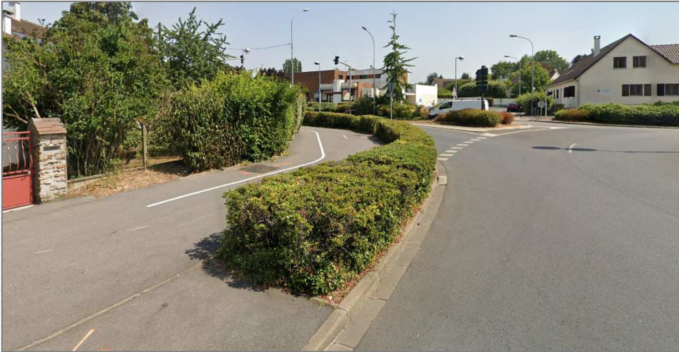
Court aménagement de voie verte autour du giratoire RD191-RD153, avec marquages séparant les 2 sens et végétation gênante.
