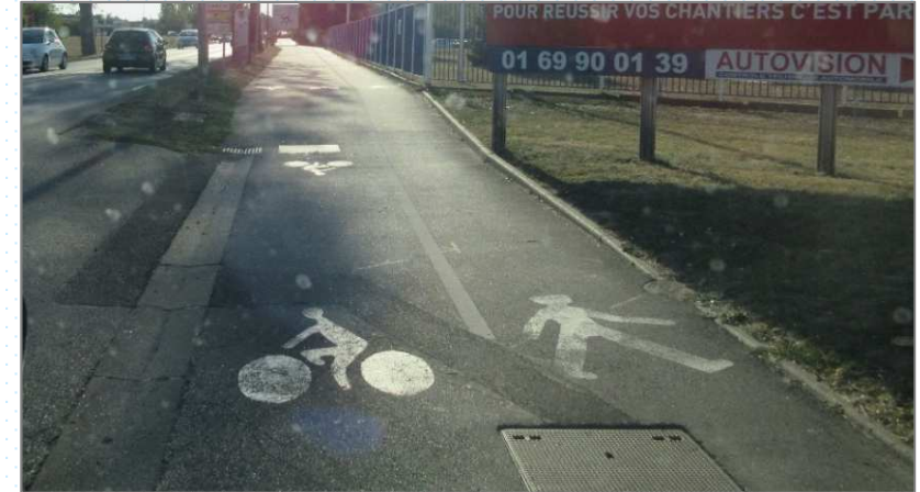
Voie verte avec séparation des modes et un manque de clarté sur les sens vélos
