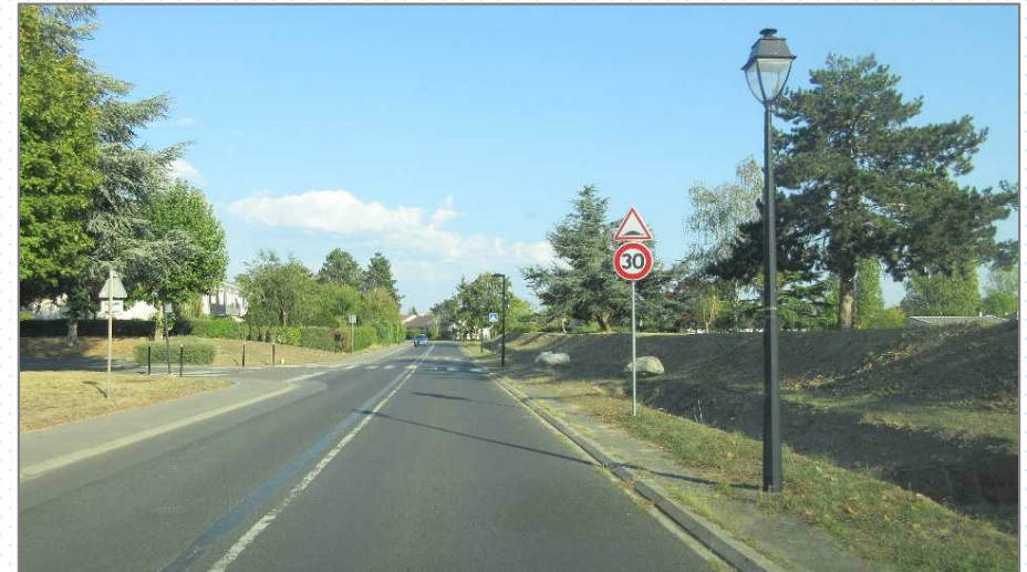
Pas d'aménagements vélos et des continuités piétonnes souvent correctes sur une seule des 2 rives
