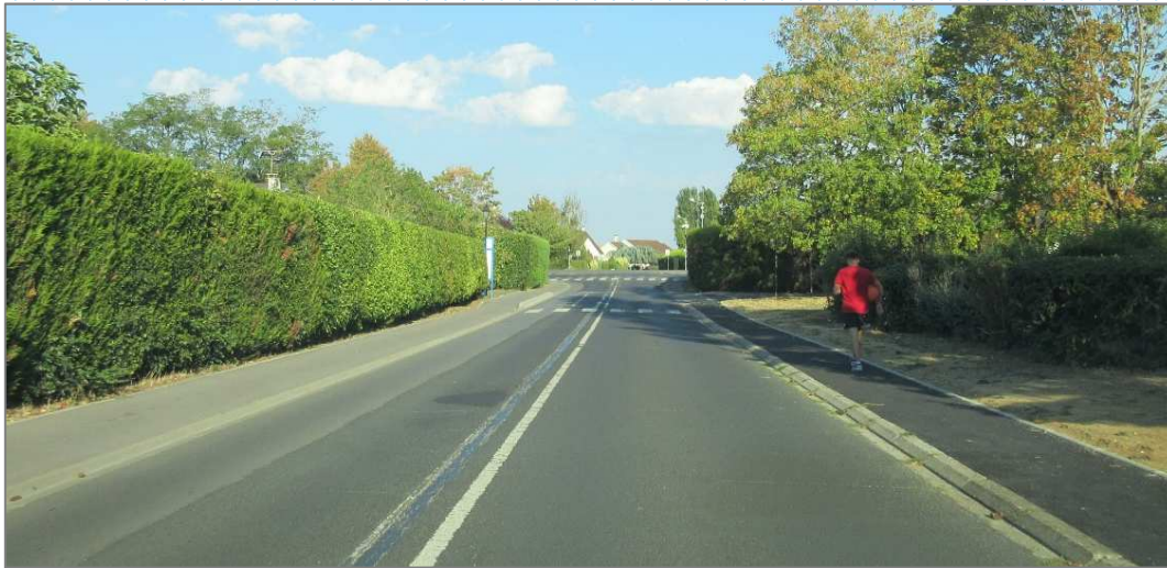
Boulevard de la Verville trop large (jusqu'à 6,50m) et rectiligne pour crédibiliser la zone 30
