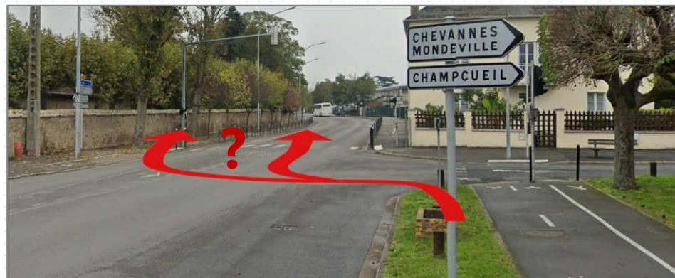
Ni marquage, ni jalonnement des continuités cyclables (ici carrefour RD191–route de Chevannes)
