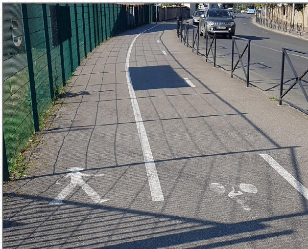
Trottoir large avec séparation des modes, mais sans bonnes continuités en amont et en aval
