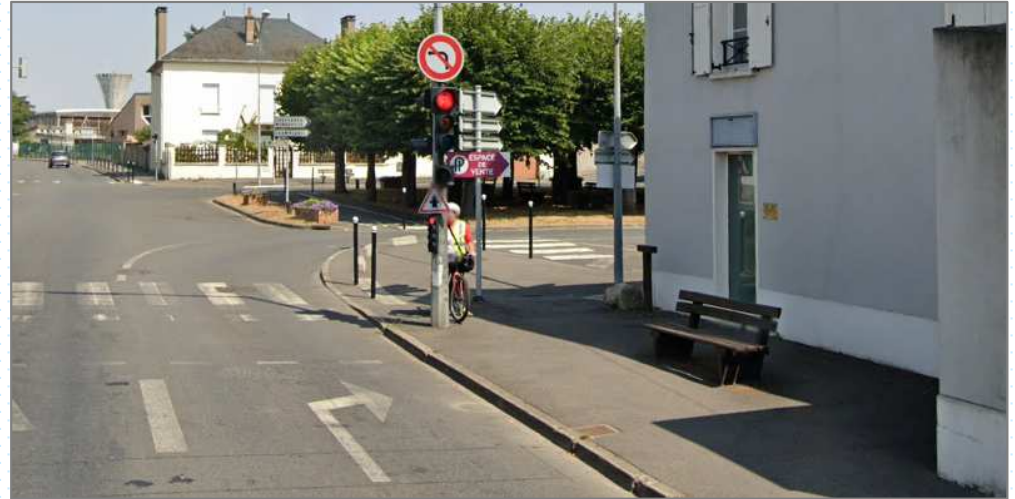
Continuité vélo difficile et insécuritaire du fait de l'absence de feux piétons/vélos, et de marquages incomplets sur le trottoir et la chaussée
