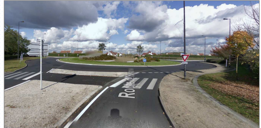
Giratoire vaste et routier, sans bande cyclable dans l'anneau, ni continuité vélo sur l'arc Sud-Est
