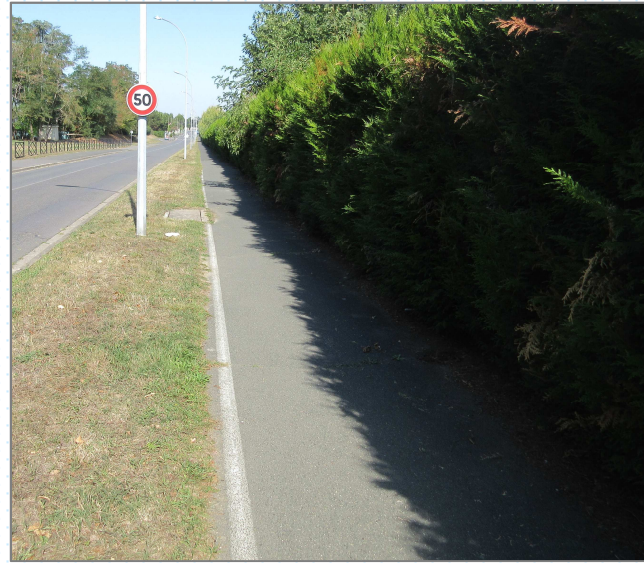
Aménagement séparé de la chaussée, sans marquage ni signalisation, mais trop étroit pour permettre une bonne cohabitation des modes actifs
