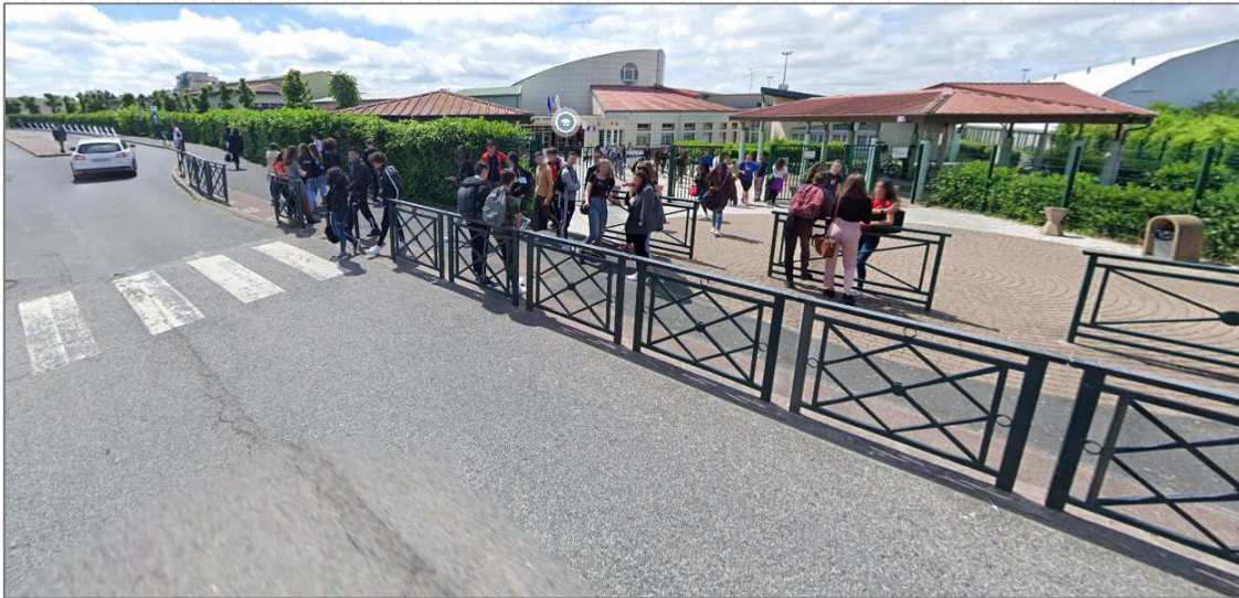
Marquages de piste cyclable bidirectionnelle, mais sans signalisation précisant la fonction de l'aménagement. Les flux piétons et le manque de crédibilité de l'aménagement entraîne une utilisation en trottoir
