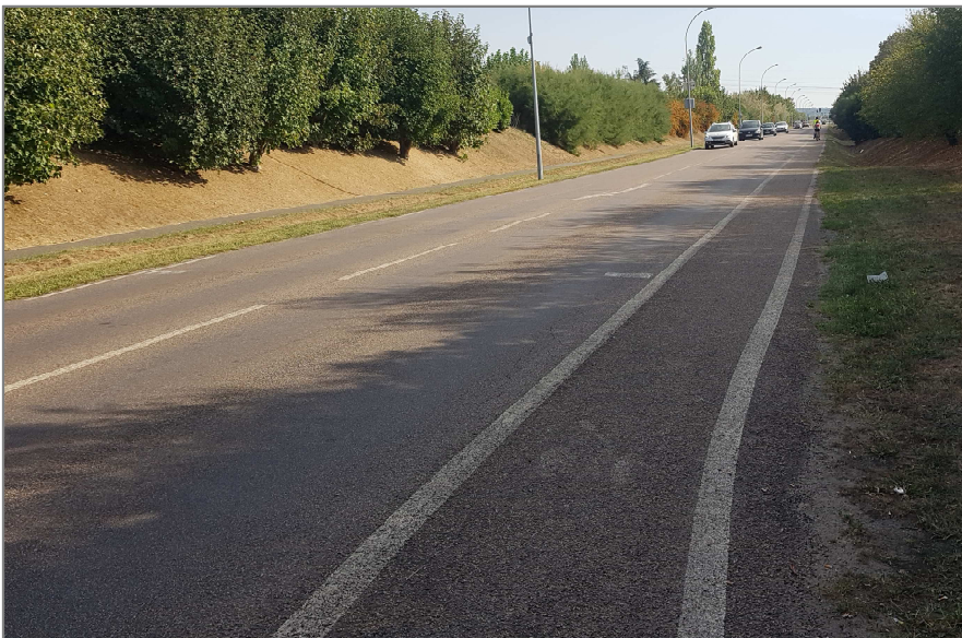
Bande cyclable trop étroite, avec aménagement séparé de la chaussée mais trop étroite en rive opposée
