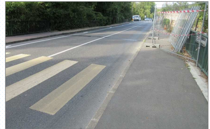
Pas d'aménagement cyclable sur la chaussée, le long de la RD153 structurante
