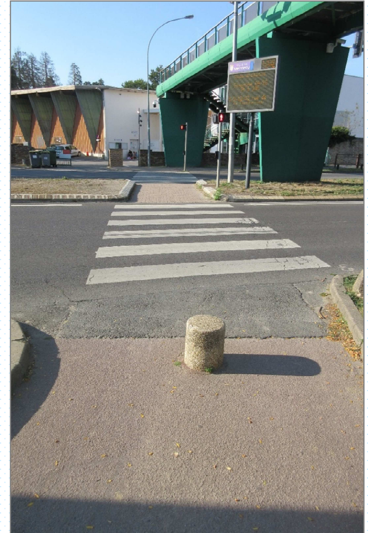
Traversée de la RD191 difficile pour rejoindre la piste cyclable (pas de traitement cyclable)
