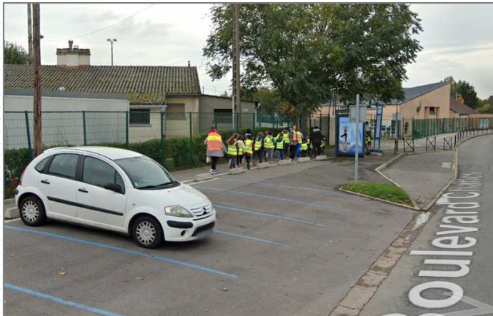
Suppression de la continuité vélo au droit d'un arrêt de bus et de stationnement trop long
