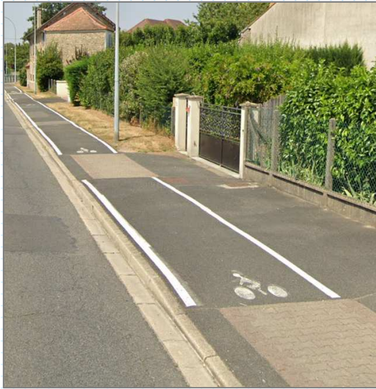
Piste cyclable sur trottoir, en conflit avec la circulation des piétons
