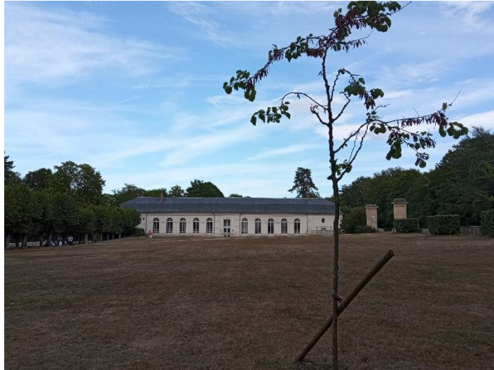
Mise à jour et mise en application du plan de gestion des espaces verts de Mennecy, avec un passage de pelouses en prairies urbaines (photo FREDON Ile de France)
