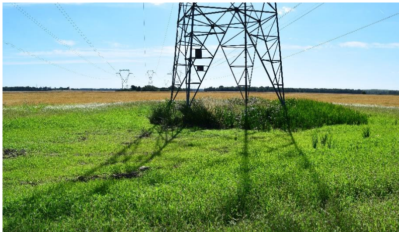
Site Mouillère aux deux pylônes (photo : Judith AUBURTIN)
