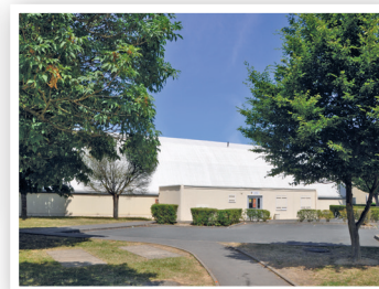
Gymnase Maurice Nivot.
